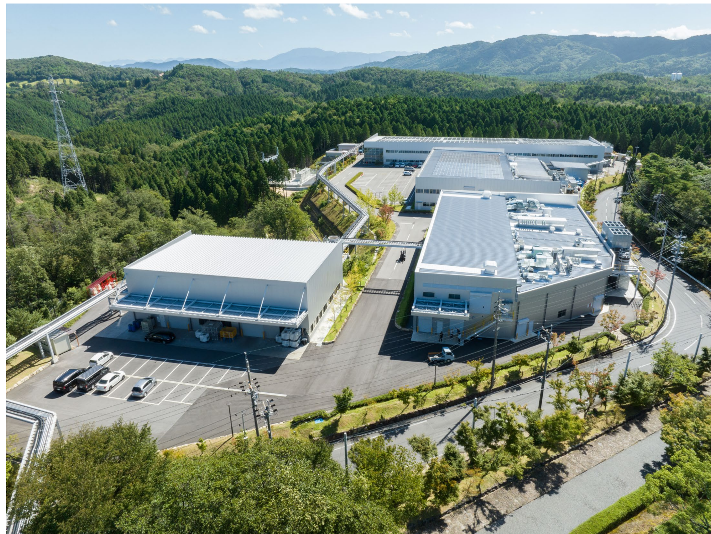
※写真手前右側の建物が新棟①
