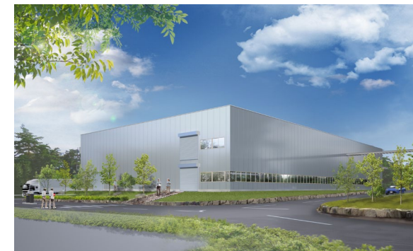
土岐工場新棟①
