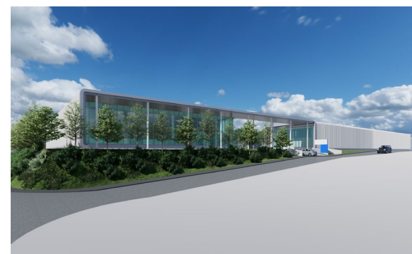
三春工場新棟
